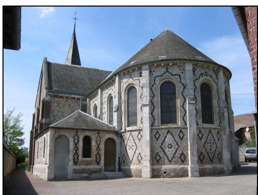
La nef, le chevet et le cœur sont reconstruits au 19 e siècle avec des silex noirs et blancs maçonnés. Les églises de Limésy et Mesnil-Panneville, probablement élevées à la même époque, adoptent un mode de construction identique.
